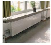
Seit Juni 2012 liefen die Bauarbeiten in der Teckschule auf Hochtouren. Für den Anschluss der Schule an die Holzhackschnitzelheizanlage mussten nicht nur 195 Nachtspeicherheizgeräte durch neue Heizkörper ersetzt werden, vielmehr musste eine Fernwärmeleitung zum Heiz-
