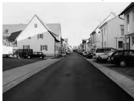
Gartenstraße nach der Sanierung
